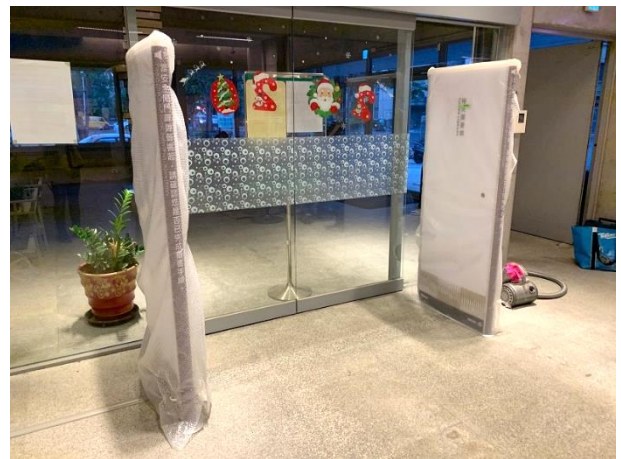
圖 37：東區裕文圖書館 RFID 設備-通道門
